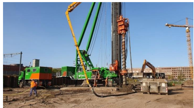
Fig. 4. Woltman 160DR drilling rig.
